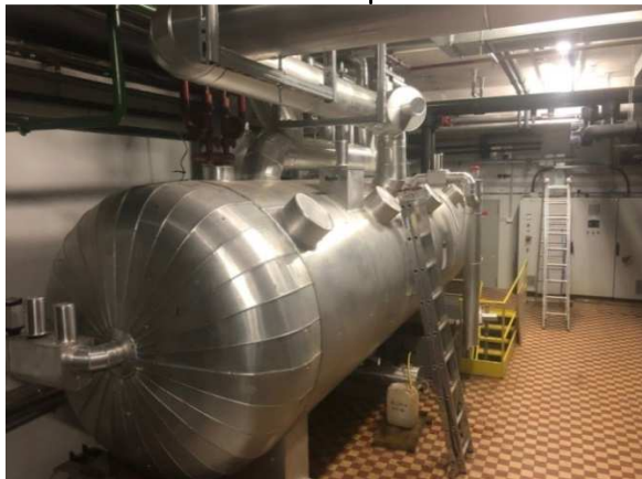
Slika 25: Separator in razvod cevi do amonijakovih črpalk v Hali Tivoli
