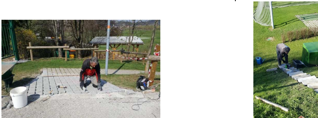
Slika 30: Postavitev tlakovcev in stopnic
