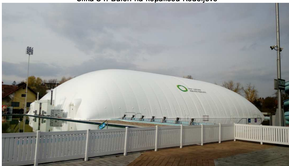
Slika 34: Balon na kopališču Kodeljevo
