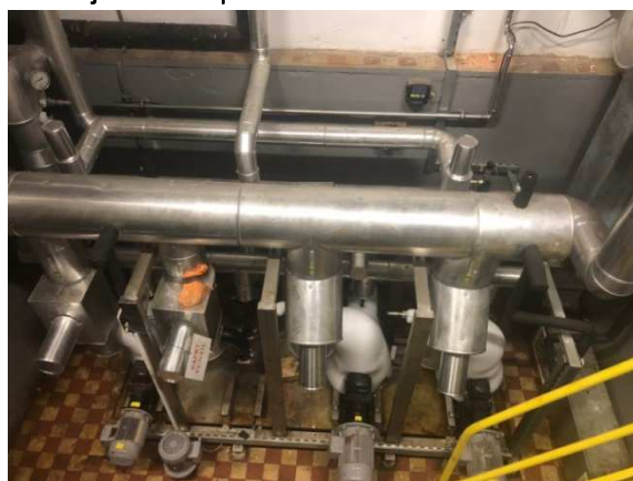
Slika 25: Separator in razvod cevi do amonijakovih črpalk v Hali Tivoli
