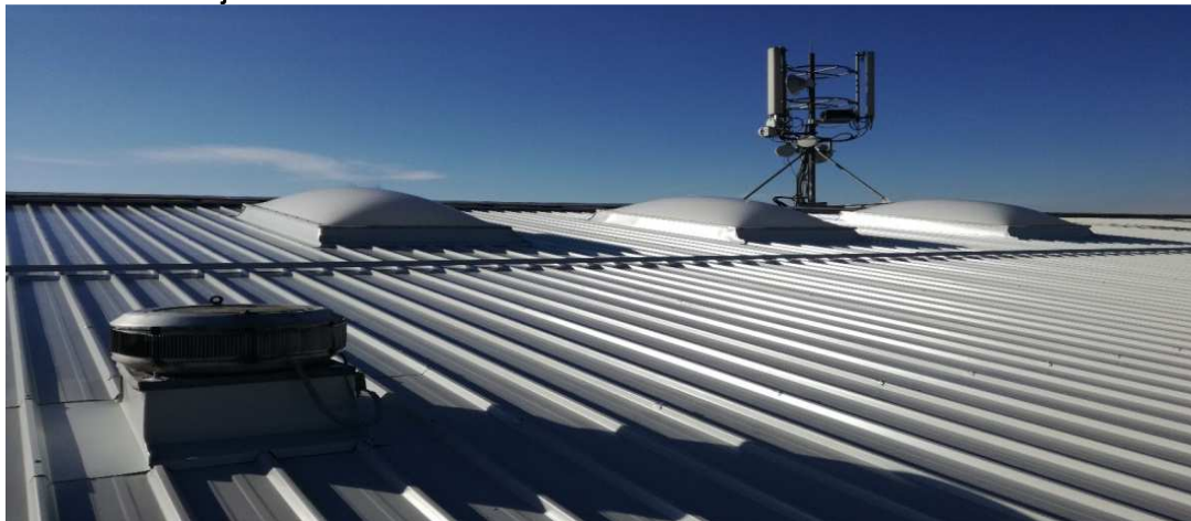
Slika 21: Obnovljena streha na dvorani Krim
